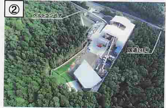
② ヤード整備工(2022年6月)
