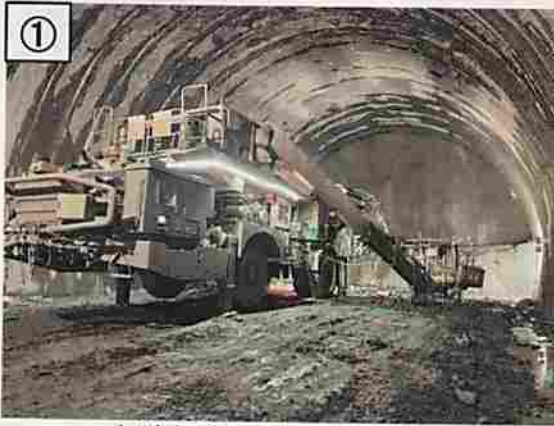
① 本坑掘削工(2025年3月)
