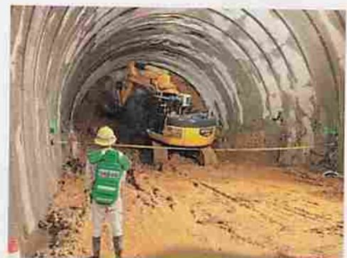
斜坑掘削(華立断層付近)
