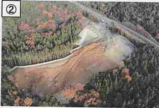
② ヤード整備工(2020年12月)
